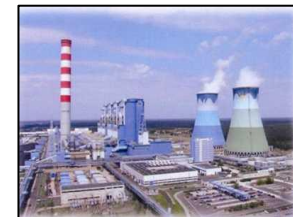
Електростанція Ополе, Польща
