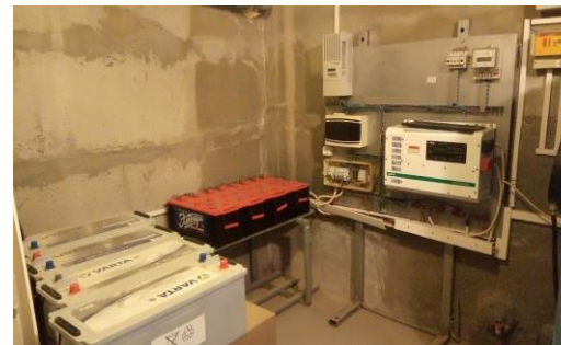
Елементи системи генерування та накопичення електричної і теплової енергії
