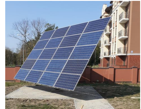
Автоматизована двоосьова трекерна система
