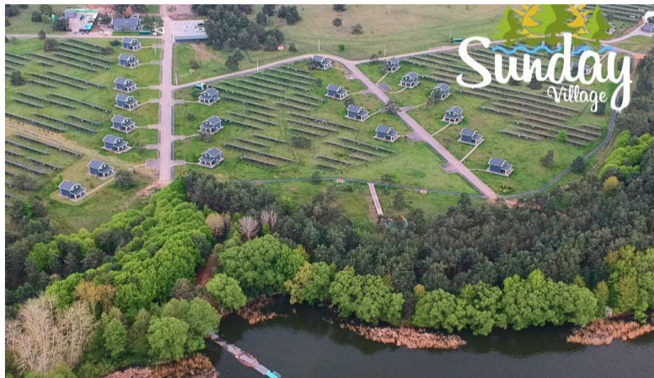
ЛЕС 10 кВ 2000 кВт, сформована з Microgrid
