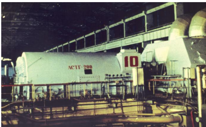
Турбогенератор АСТГ-200 з 1985 року успішно експлуатується на Буритинській ДРЕС.
